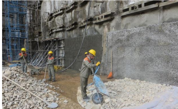
شکل ۹- دیوار تراوا اجرا شده در پروژه نگین افق نیایش
