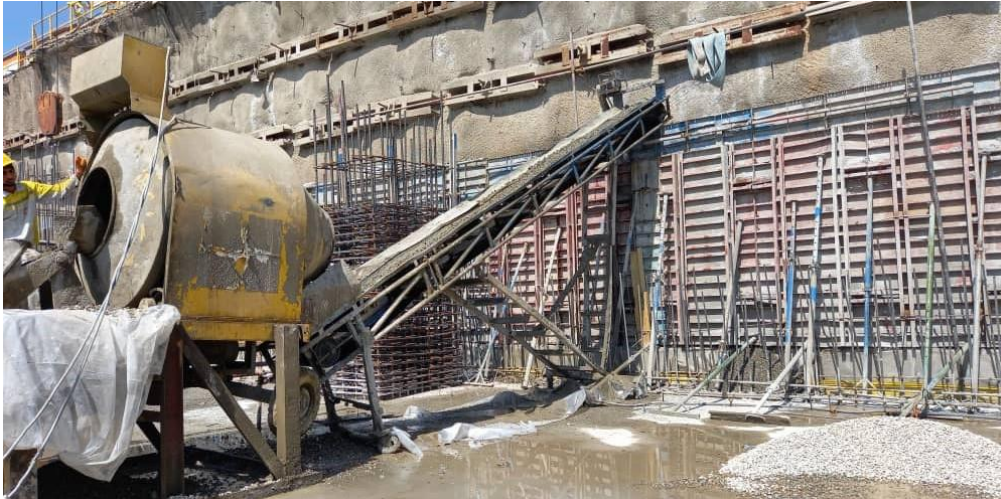
شکل ۷- اجرای بتن تراوا در پروژه نگین افق نیایش
